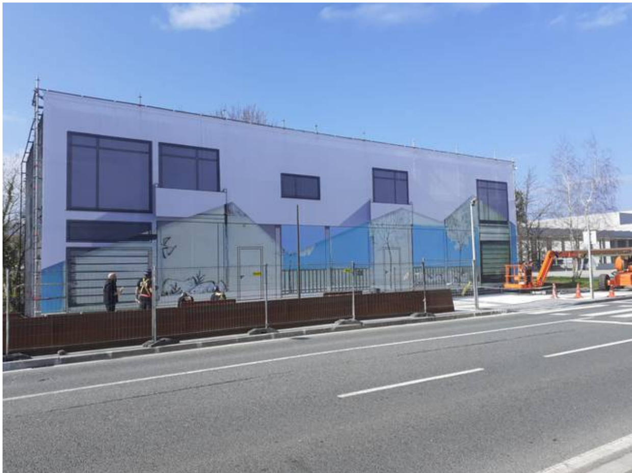
Lona colocada en la Casa Taller Basterretxea-Oteiza de la Avenida Iparralde. / Ayuntamiento Irun
